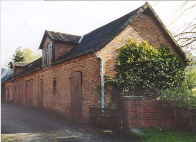
Dach und Fassade DE Armsen
