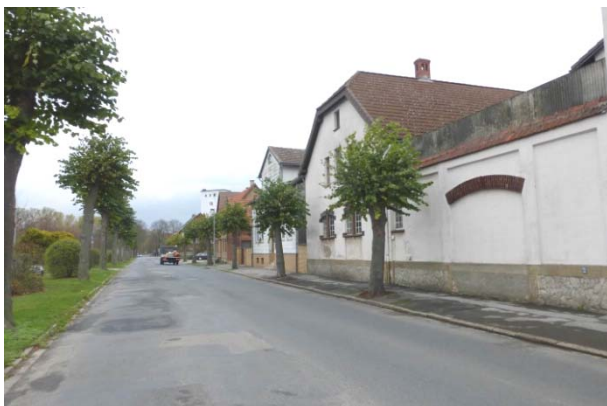
West: Hindenburgstraße - Sanierung
