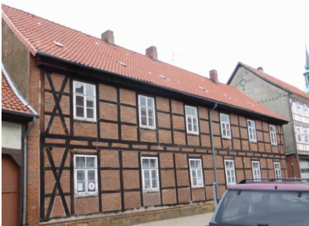
Gebäude mit typischen Andreaskreuzen aus der Zeit ab Mitte des 19. Jh. bis um die Jahrhundertwende, Pfettendachkonstruktionen überwiegen allmählich
