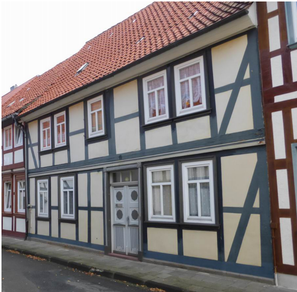
Beispiel linkes Foto: Strebenverlauf: Schwelle-Eckständer - Foto rechts: wie linkes Beispiel, jedoch im Erdgeschoss zweidrittelwandhohe Strebe
