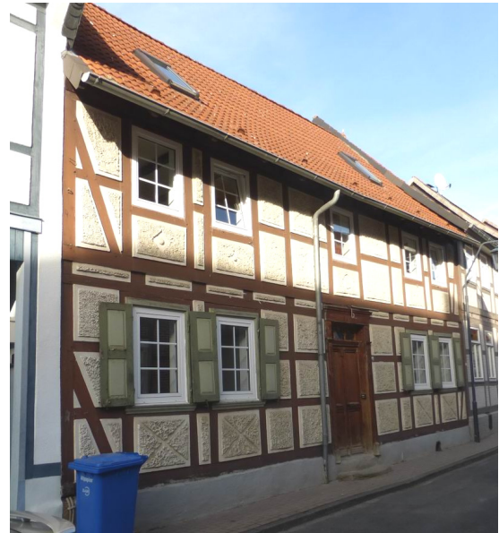
Beispiel linkes Foto: Strebenverlauf: Schwelle-Eckständer - Foto rechts: wie linkes Beispiel, jedoch im Erdgeschoss zweidrittelwandhohe Strebe
