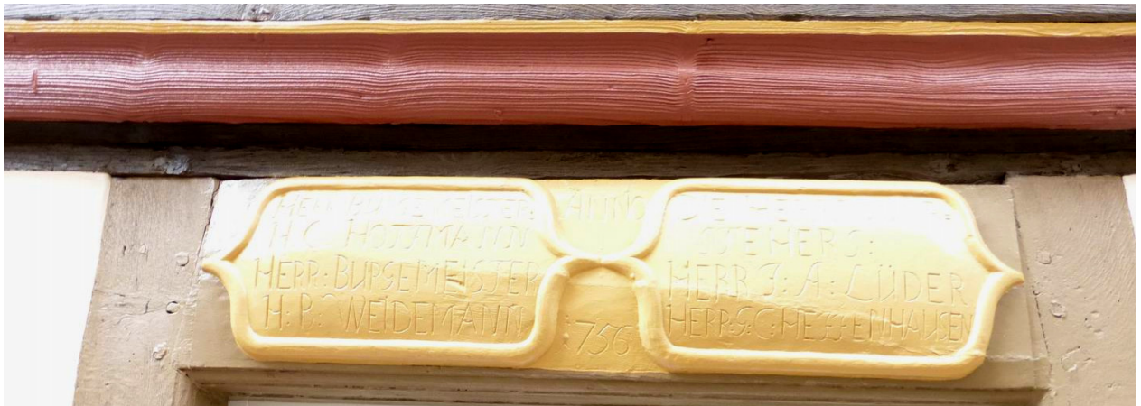
Türsturz mit Inschrift am Beguinenhaus
