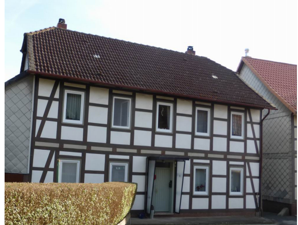
Sog. „Fünf-Fensterhaus“ mit symmetrischem Fassadenaufbau; Strebenverlauf Schwelle - Rähm meist bei den jüngsten Fachwerkbauwerken:
