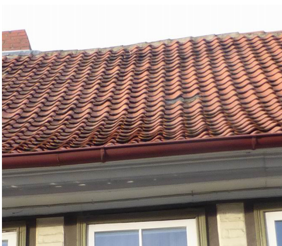
Typische naturrote Hohlpfannenlandschaft, typischer „gekalkter“ weißer Dachkasten aus Holz als Detailaufnahme (linkes Foto), Dachrand mit Dekorelementen (Foto rechts).
