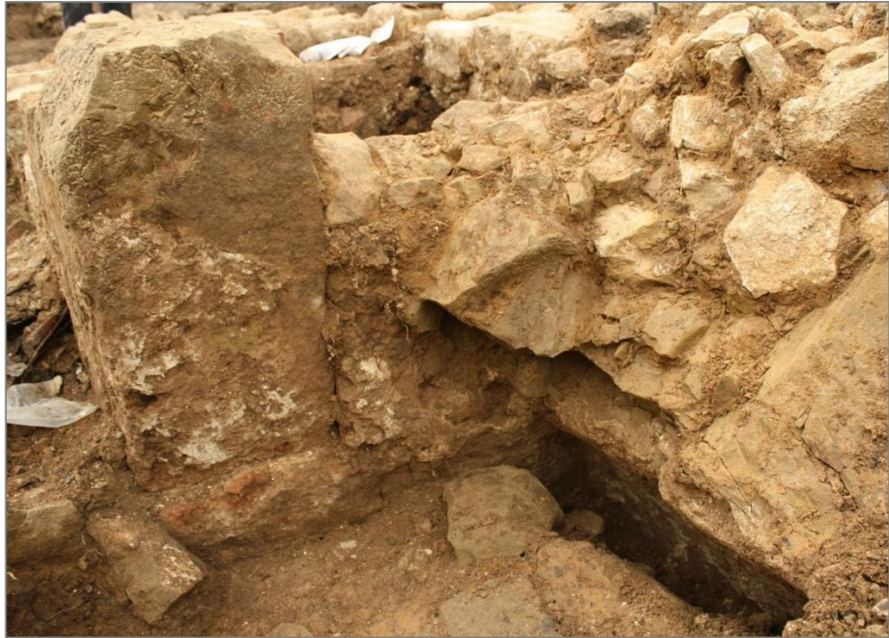
Abb. 57: Bockenem FStNr. 7, Gewölbeansatz aus Kalkbruchstein und Buntsandstein, die Innenseite war mit Kalkputz versiegelt. Auf der linken Bildhälfte zu sehen ist die Sandsteinspindel der kleinen Wendeltreppe. (Foto: Arcontor Projekt GmbH, 07.09.2021)
