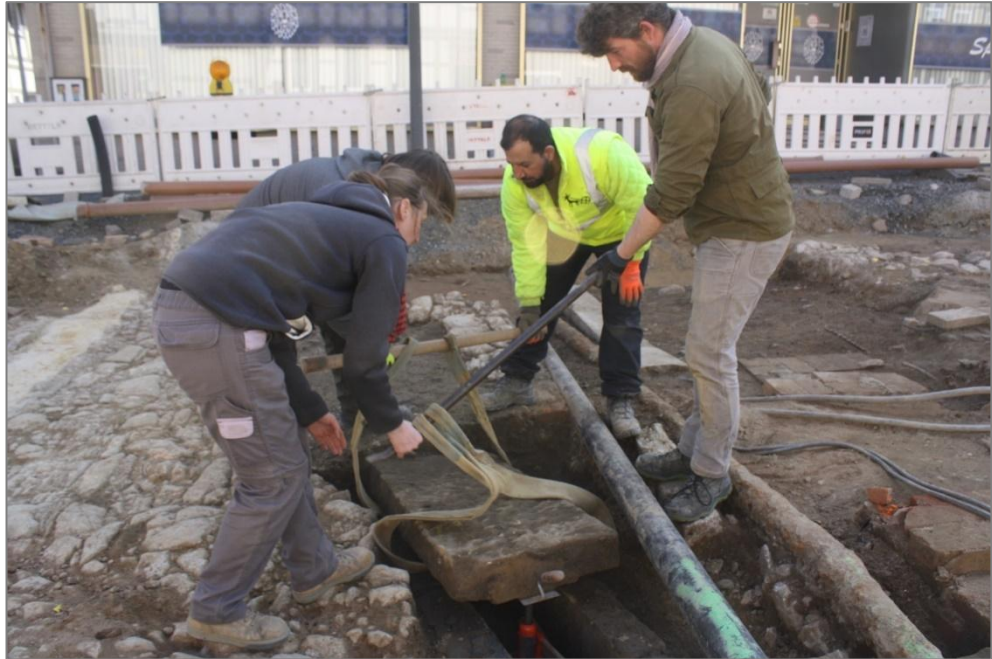
Abb. 50: Bockenem FStNr. 7, Die Bergung der Deckplatte der Sandsteinwasserleitung gestaltete sich schwierig: aufgrund der Rohre war der Einsatz des Baggers unmöglich. Stattdessen musste die große Sandsteinplatte per Hand von vier Personen bewegt werden. (Foto: Arcontor Projekt GmbH, 28.03.2022)
