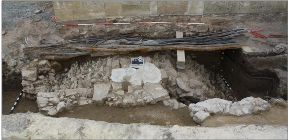
Abb. 30: Bockenem FStNr. 7, Gewölbekappe, Schildwand und Fundament des Gewölbekellers unter dem heutigen Turmuhrenmuseum. Deutlich ist die über den Keller geführte Starkstromleitung zu erkennen. (Foto: Arcontor Projekt GmbH, 10.05.2022)
