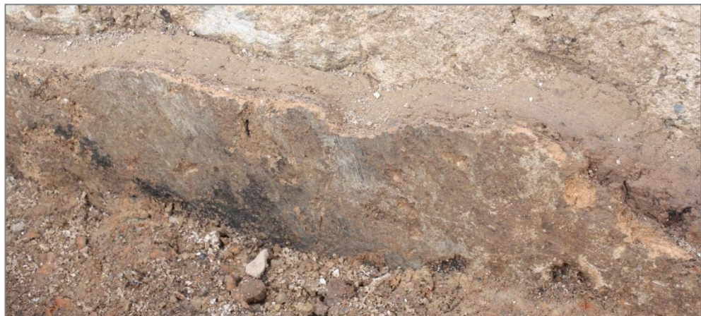
Abb. 21: Bockenem FStNr. 7, Der Unterputz Bef. 1082 mit darüberliegendem Kalklehmputz Bef. 1083. Deutlich sind die Wischspuren aus Bef. 1083 in der linken Bildhälfte zu erkennen. (Foto: Arcontor Projekt GmbH, 27.04.2022)
