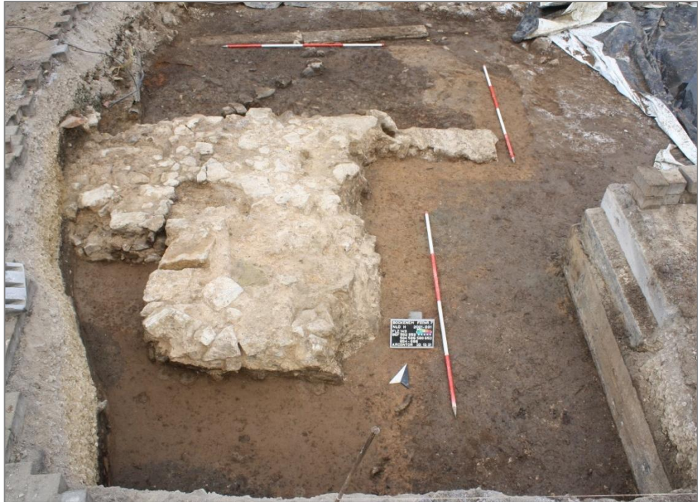
Abb. 13: Bockenem FStNr. 7, Nordwestliches Rathauseckfundament Bef. 588, westlich setzt der Fundamentblock Bef. 666 dagegen. Deutlich zeichnet sich eine Baufuge zwischen den beiden Befunden ab. Im Osten ist deutlich die Störung durch den Einbau der Löschwassersisterne (rechter Bildrand) zu erkennen. (Foto: Arcontor Projekt GmbH, 22.12.2021)
