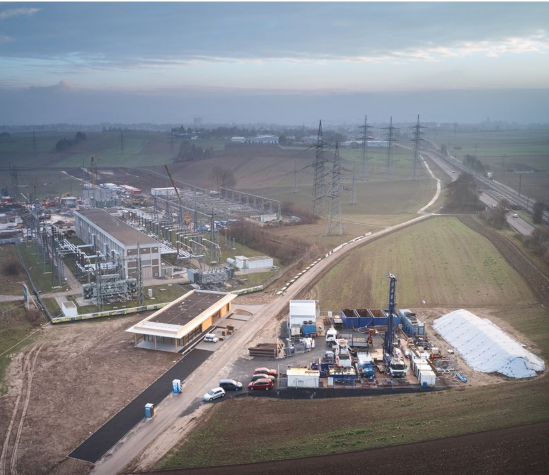
Bohrplatz für Erkundungsbohrungen rechts und gegenüber des Infocenters
