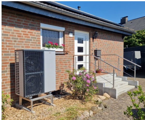
Luftwärmepumpe
