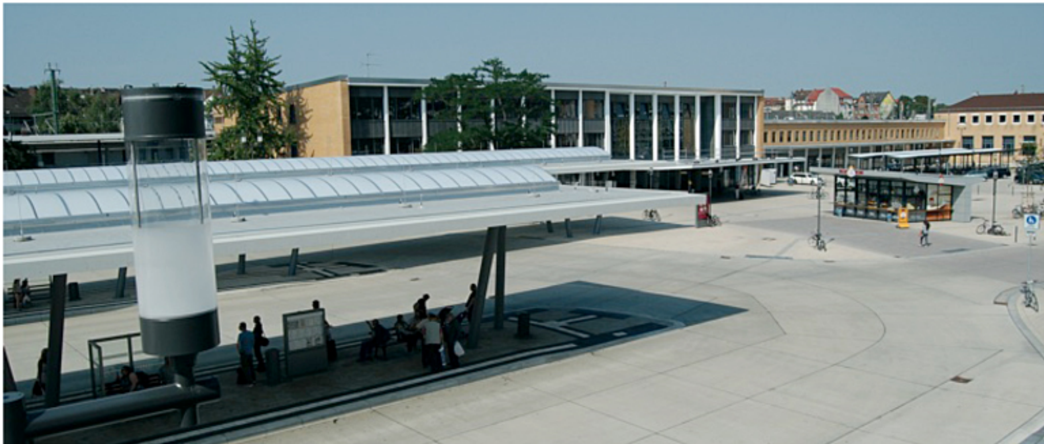
Im Sommer 2016 sollen die Umbauarbeiten am Hauptbahnhof abgeschlossen sein. Damit wurde das gesamte Umfeld einem kompletten Wandel unterzogen.
