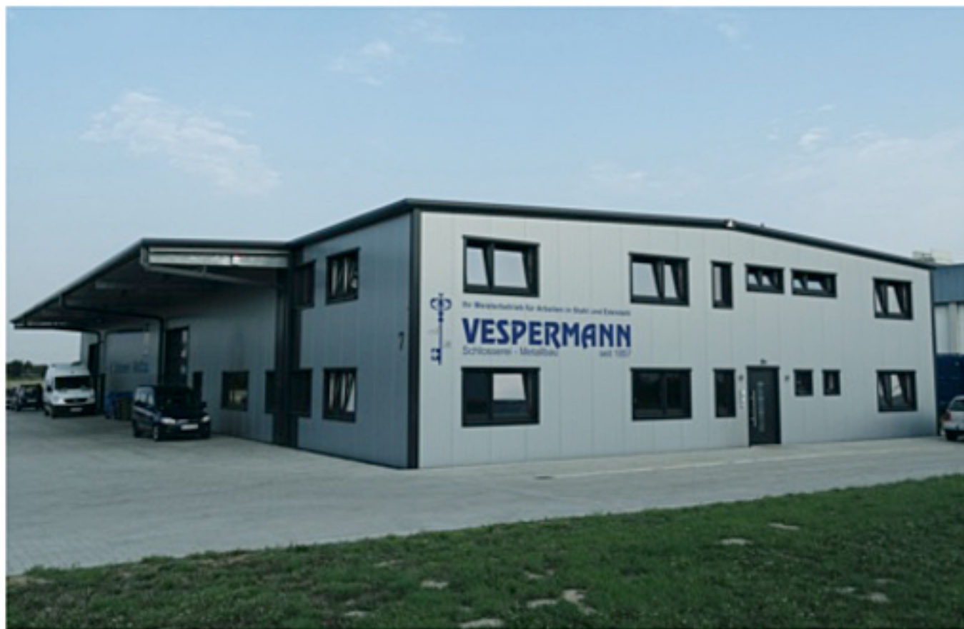
In einer neuen Halle hat seit kurzem der Schlosserei- und Metallbaubetrieb Vespermann seinen Sitz. In der direkten Nachbarschaft will Geschäftsführer Andreas Beike eine weitere Halle bauen und an Dritte vermieten. Foto: Metallbau Vespermann Inh. Andreas Beike e.K.
